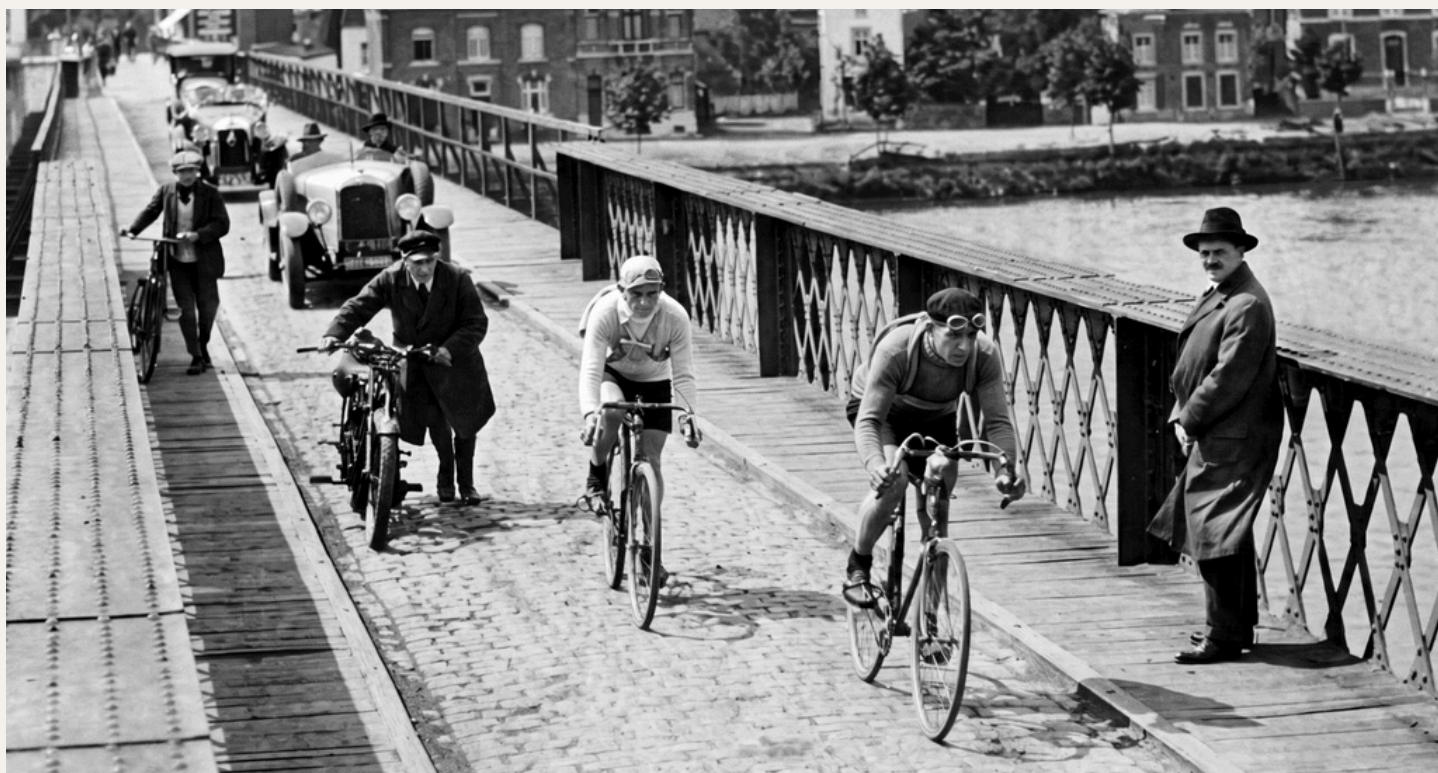
Jules Van Hevel et Julien Delbecque assomment littéralement la course dès le premier jour. Le duo traverse ici le pont de Visé avant de se jouer la gagne dans la cité principautaire (photo Sports illustrés)
